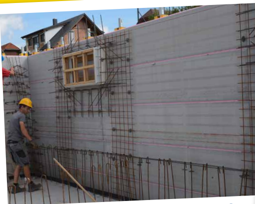
Aussparungen und Bewehrung der Wand
