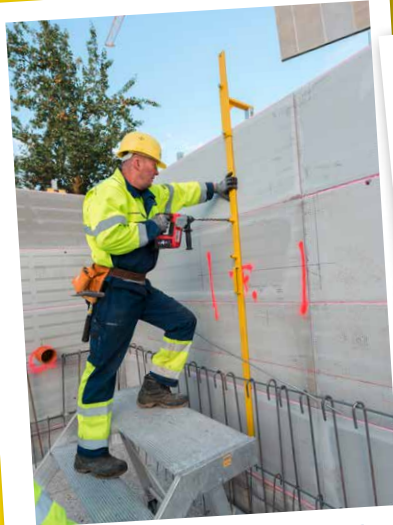
Bohrung der Ankerlöcher
