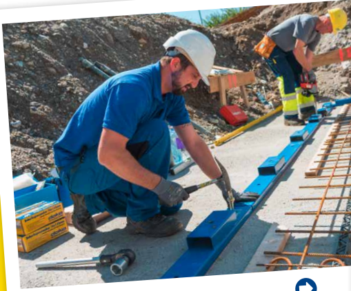
Montage der Bodenschienen
