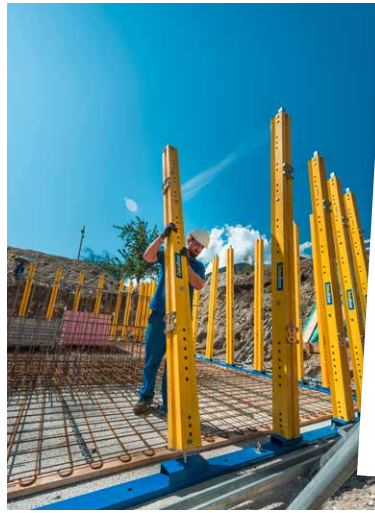
Errichten der Stützkonstruktion
