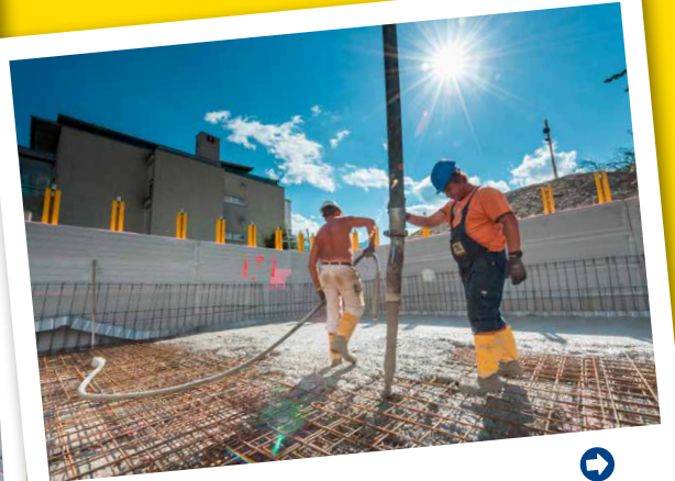
Betonage der Bodenplatte
