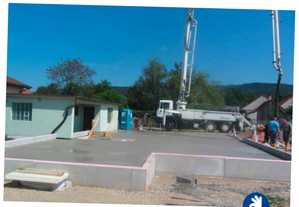
Betonage der Wände und Decken
