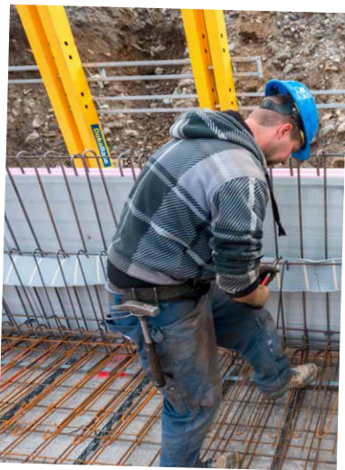
Einbau von Bewehrung und Installation
