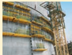
Ruwais LNG Tanks
