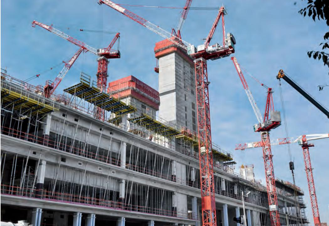
▲ Les éléments préfabriqués sont positionnés en rive des dalles à l'aide de tables coffrantes Dokamatic. L'étaieiment Staxo 40 est mis en œuvre dans la grande salle des pas perdus.
