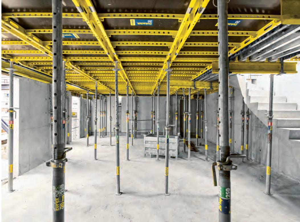
▲ Fort taux de réemploi pour les coffrages modulaires Dokadek 20 qui ont permis de coffrer l'ensemble des planchers des 10 niveaux du bâtiment en toute flexibilité, y compris avec le système tec-2 pour les compensations.
