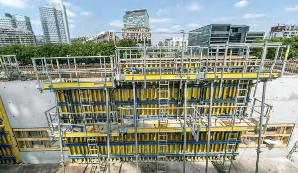
◀ Les grands voiles qui dessinent la forme de la Cité musicale au-dessus de la Seine sont coffrés avec les banches Doka Top 50 équipées de peau coffrante Xface pour produire des parements béton de haute qualité.
