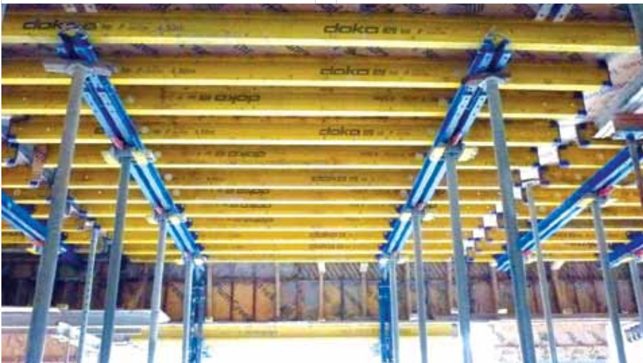
◀ El montaje de los componentes funcionales estandarizados es extremadamente fácil reduciendo hasta un 50% los gastos de mano de obra
