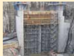
Central Hidroeléctrica Angostura
