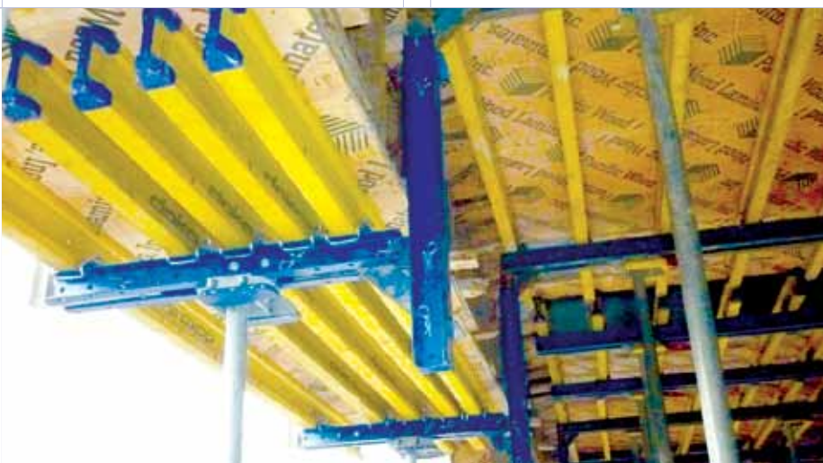
◀ Los sistemas Doka permitieron disponer fácilmente las vigas descolgadas de 1,20 m
