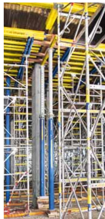
▲ DokaのフロアプロップEurex 60とStaxo 100およびStaxo 40を組み合わせた充填ソリューションにより、形成が格段に容易になります。
