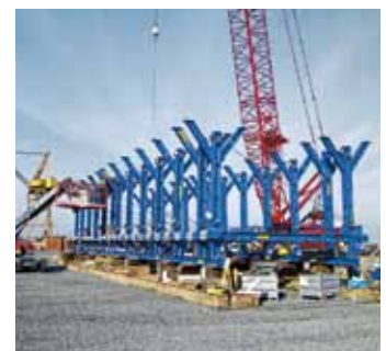
▲ 乾ドックにて準備中の水中第2ミッドタウン・トンネル。
