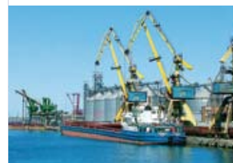
▲ 2007-2008: Silozuri Port Constanța
