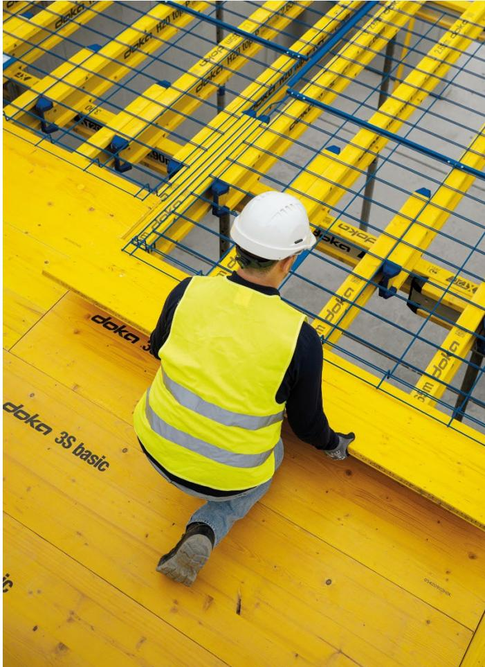
*Deutlich erhöhte Sicherheit: Das Safeflex-Schiebegitter ist nach DGUV Test GS-Bau-18 geprüft.*
