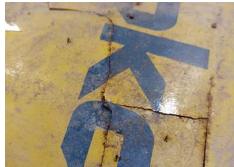
Pukotine na ploči > 10 cm dužine
