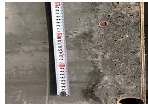
Spaljena ploča površine >10 cm
