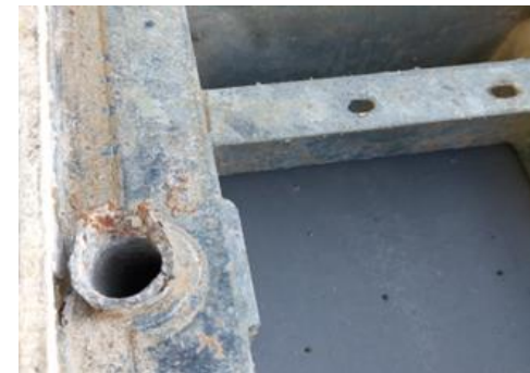
1. Zaštita za sidra koja nedostaje/oštećena je
