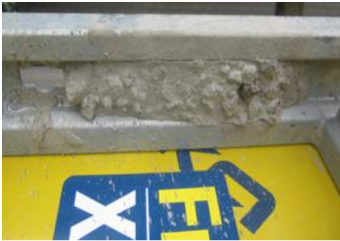
Unutrašnjost profila okvira ispunjena betonom
