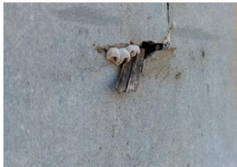
Rupe + provrti promjera > 2 cm
