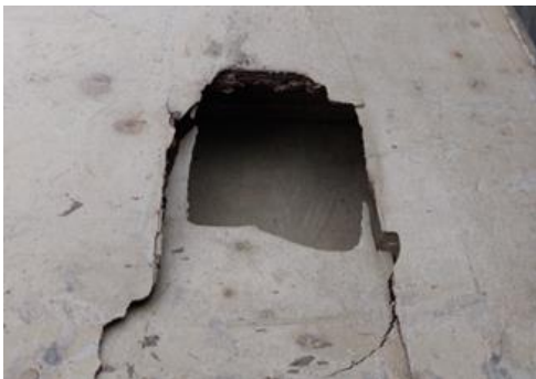
Rupe + provrti promjera > 2 cm
