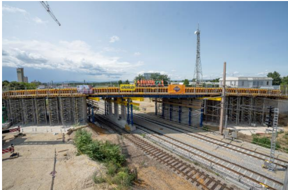
Erneuerung der Bockfließbrücke über die Nordbahn mit Doka UniKit. © Doka
