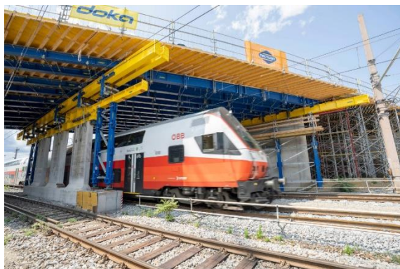
Das Lehrgerüst aus dem mietbaren Baukastensystem UniKit bot ausreichend Platz für das Lichtraumprofil. © Doka
