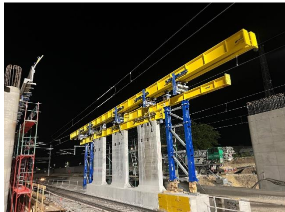
Aufrüsten des Mittelpfeilers – digital und real. © Doka/Swietelsky
