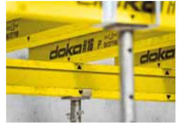
▲ '1-2-5' 시스템 그리드와 고유의 빔 간격 표식은 대폭적인 포밍 작업 시간 단축과 높은 안전성을 지원한다.
