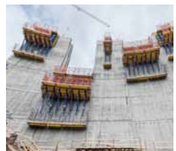
▲ 댐 폼웍 D35의 시작: 새로운 Doka 표준 시스템이 노르웨이 "Sarvsfossen 댐" 건설에 최초로 사용되고 있다.
