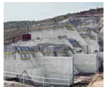
▲ Doka의 역사는 발전소 건설과 밀접한 관련성이 있다. 스페인의 카스트로비도(Castrovido) 댐과 같은 국제적인 발전소 프로젝트에서 축적된 수십 년의 경험은 건설 프로젝트를 이행하는 동안 Doka 고객에게 유익하게 활용된다.
