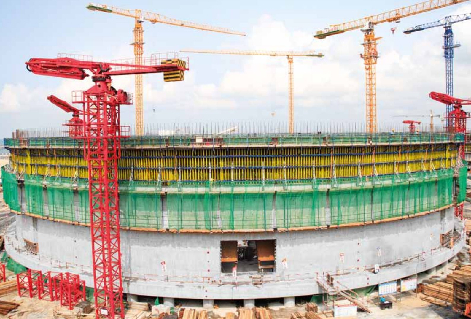
▲ 광시성 베이하이 LNG 프로젝트 건설 현장
