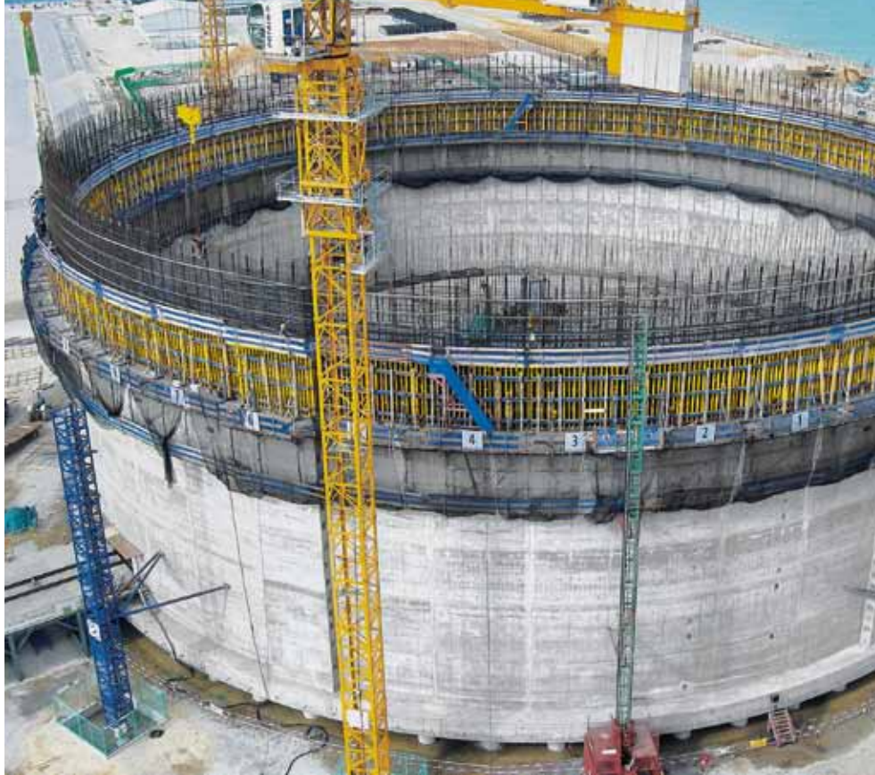
▲ 크레인 인양 클라이밍 폼웍 MF240은 지름 82m에 높이 52m인 태국 망타퓏( Map Ta Phut) LNG 저장탱크를 건설하는 동안 체계적인 포밍 공정과 신속한 시공 진척도를 보장했다.
