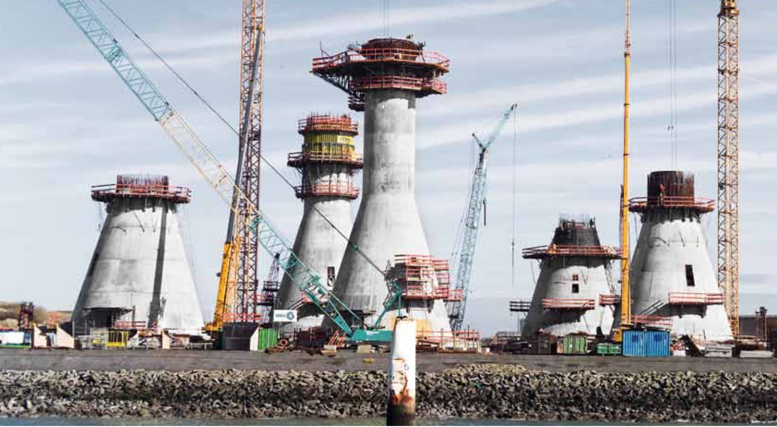
▲ Doka 시스템은 벨기에의 쏘튼 제방(Thornton Bank) 해상 풍력 단지 등에서 풍력 터빈을 시공하는 동안 탐과 기초에 사용된다.
