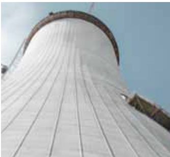
▲ Doka는 슬로베니아 쇼슈타니(Sostanj) 석탄 화력발전소의 164m 높이 냉각탑 건설을 위해 콜링 타워 품목 SK175에 토대를 둔 품목 솔루션을 공급했다. 1.50m 높이의 타설 섹션을 위한 셉프 클라이밍 시스템을 통해 극도로 짧은 주기에서도 정밀한 포밍 작업이 가능하다.
