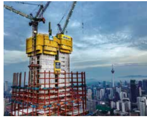
▲ 前瞻性的模板设计——从开始之际，便将塔吊考虑在模板方案之中。所以现在实现了塔吊的无缝整合。多卡还提供了所有的照明标志。
