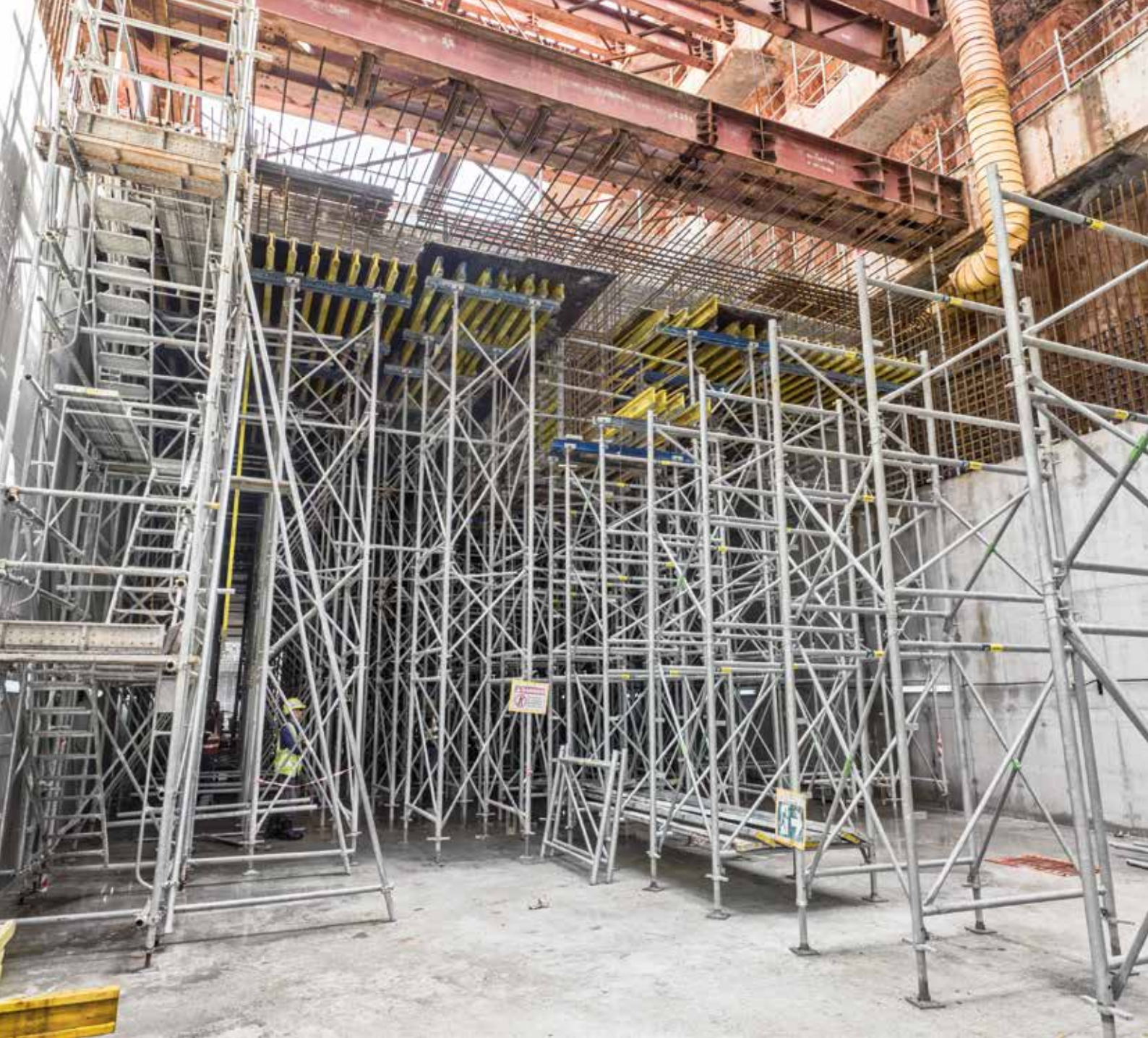
▲ 用于楼板结构的多卡d3支撑塔架系统。
