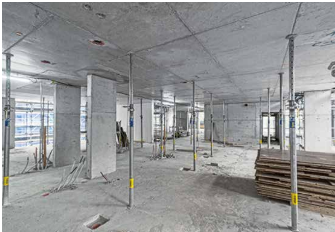
▲ 模板脱模后，混凝土表面质量均匀、干净。
