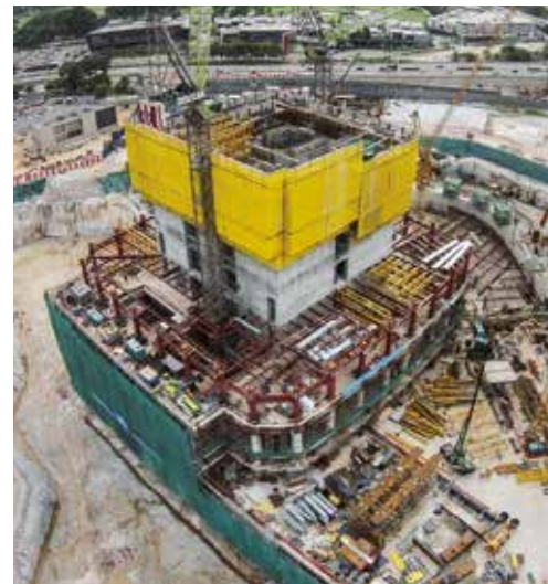
▲ 建筑核心筒分为两部分，正在使用自动爬升模板SKE100 plus和SKE50 plus进行建造。在单次操作中，可以使用液压千斤顶将一个部分的整个外部进行重新定位。
