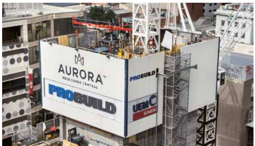
▲ Aurora项目的Lubeca主导系统，包括塔吊和布料机的容纳空间。
