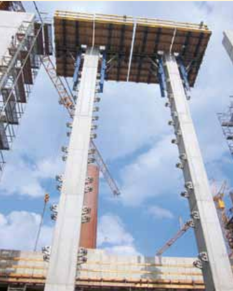
▲ 26,80 m hohe, freistehende Einzelstützen im Querschnitt von 1,00 x 1,00 m mit Klettersystem Xclimb 60 geschalt.
