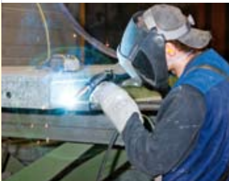
▲ Fachmännische Schweißarbeiten führt geprüftes Personal aus dem zertifizierten Geräteservice durch.
