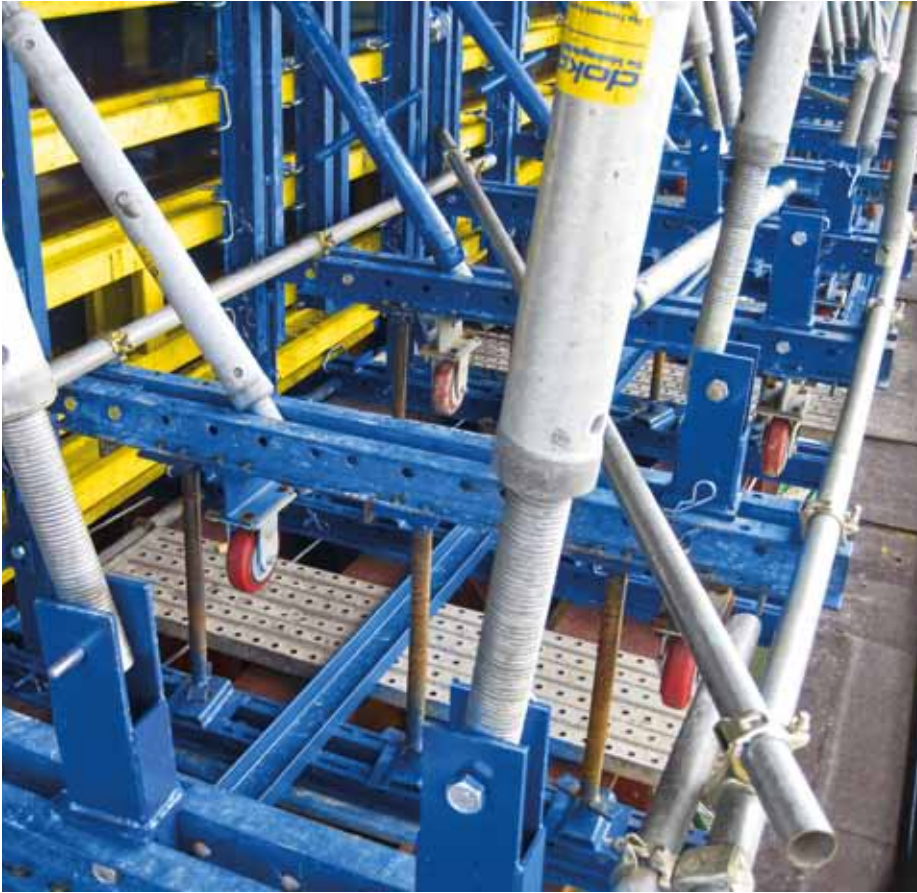
◀ 桥面板和侧壁模板设计在滚轮上推进。无需塔吊协助，所以现场效率得到提高。
