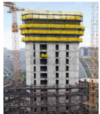
▲ 多卡为该项目供应了自动爬升模板 SKE50 和大面积模板 Top 50，节约了塔吊时间并加快了大楼施工进度。
