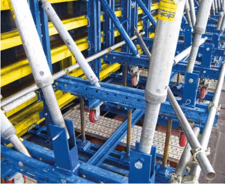
◀ 측벽과 데크 슬래브에 사용하는 폼웍은 롤러 위에서 전진할 수 있도록 만들었다. 크레인이 필요 없으므로 효율성이 증대된다.
