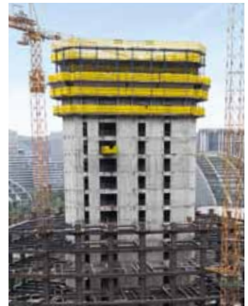
▲ Doka는 이 프로젝트에 오토매틱 클라이밍 폼웍 SKE50와 대형 패널 폼웍 Top50을 공급하여 타워-크레인 시간을 줄이고 공사 진행 속도를 높이고 있다.
