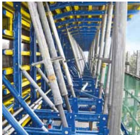
▲ 슬래브와 측벽 폼웍은 콘크리트의 무게를 줄이고 안전을 강화하는 작업 플랫폼으로 사용할 수 있도록 만든 대형 패널 Top50으로 이루어져 있다.
