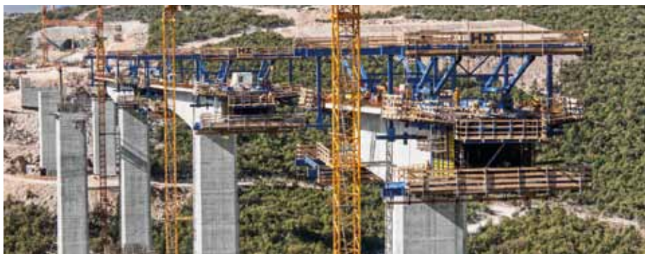
▲ 길이 555m와 365m에 이르는 교량 건설을 위해 Doka는 캔틸레버 포밍 트레블러로 구성된 폼웍 솔루션을 개발했으며, 타설 구간 확장 덕분에 시간과 자원을 절약할 수 있었다.
