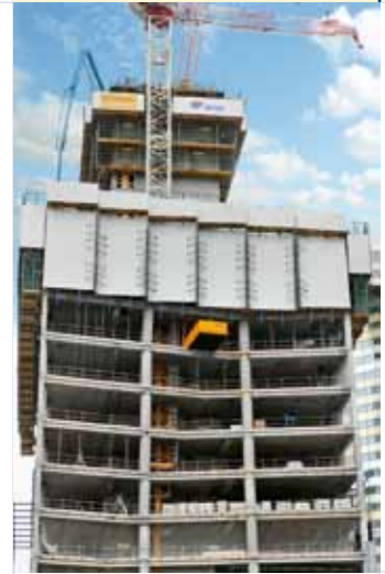
▲ 빌딩 외관의 포밍 작업을 보호하기 위해 구조물의 넓은 부분에 자동 클라이밍 폼웍 SKE50 플러스 시스템의 11개 플랫폼이 사용되며, 좁은 부분에 12개의 프로젝션 스크린 Xclimb 60 플랫폼이 사용된다.
