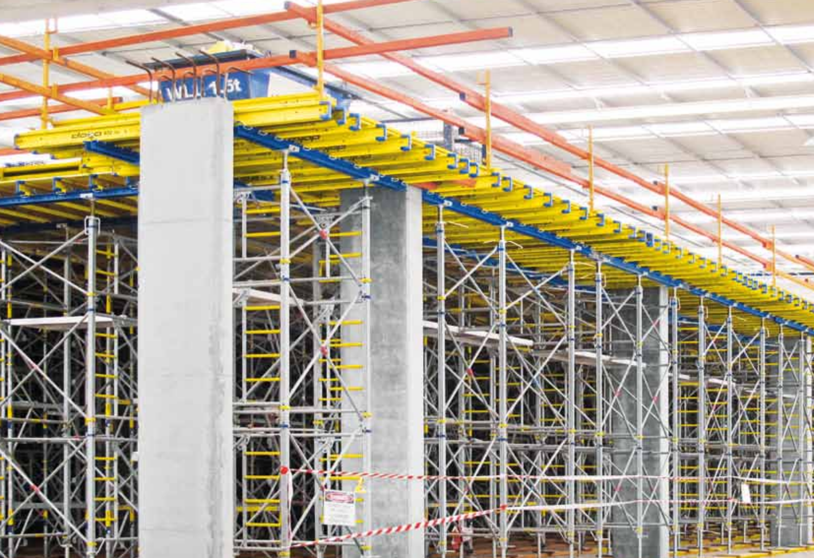
▲ 大量支撑塔架 Staxo 100 和 Staxo 40 得到安全快速地架设。
