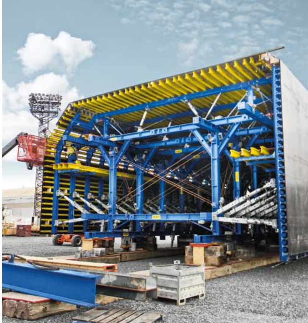
▲ 高性能‘高承载力支撑系统 SL-1’隧道模板与大面积模板 Top 50 的组合非常适合于第二条沉埋式中城隧道 11 个隧道段的箱室截面。
