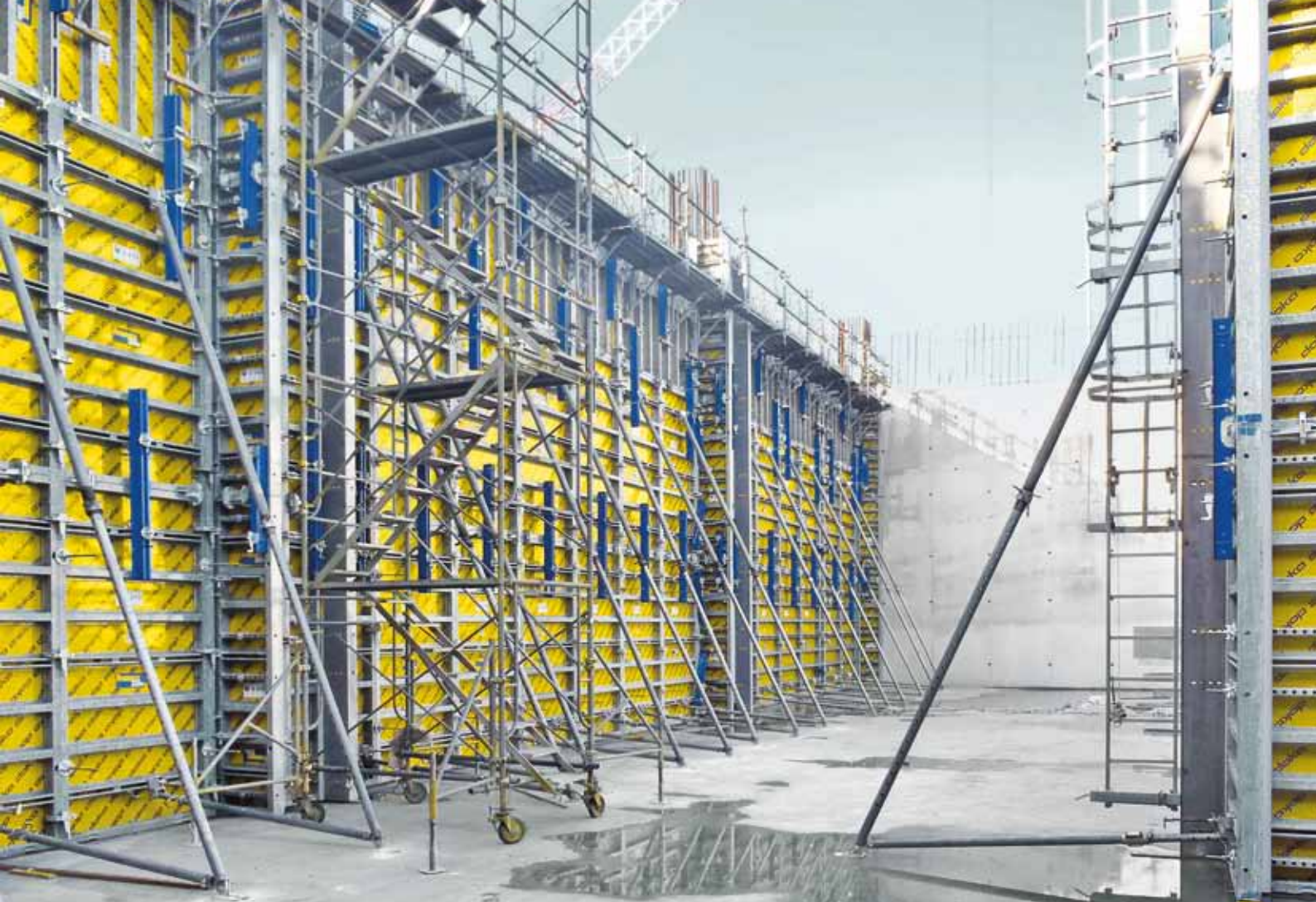
▲ 使用的模板总面积达到 1,700 m 2 各层以 4 天为周期采用 6 班轮流作业。
