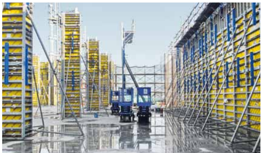
▲ 通过配置的8套柱模和1400 m 2 墙模,多卡获得了很高的声誉。
