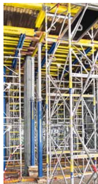
▲ 多卡 Eurex 60 支撑结合 Staxo 100 和 Staxo 40 共同构成解决方案，可大大方便组模作业。
