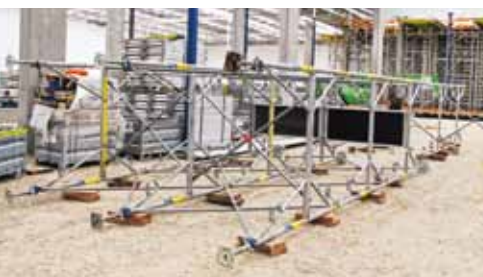
▲ 地面塔架组装让 Staxo 100 和 Staxo 40 成为市场中最安全的产品并且可以加快组拼周期。
