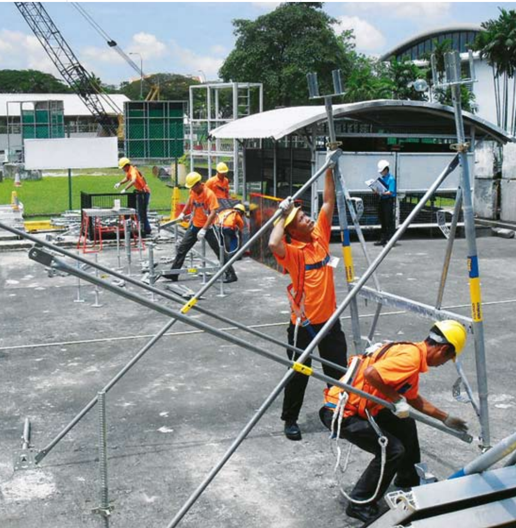
◀ 새로운 제품 로드-베어링 타워 Staxo 40의 조립 속도 및 간편한 작업에 대해 모든 참가자들이 깊은 인상을 받았다.
