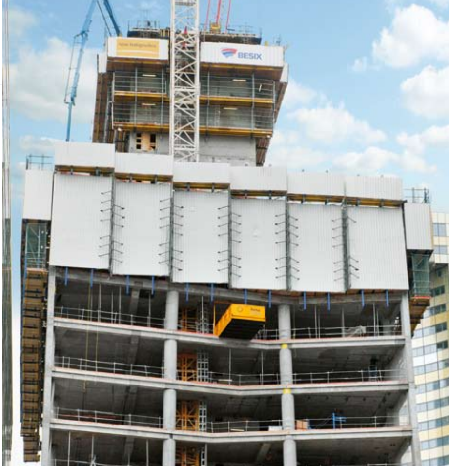
◀ La protection de façade Xclimb 60 de Doka s'adapte à la géométrie complexe de l'ouvrage.
