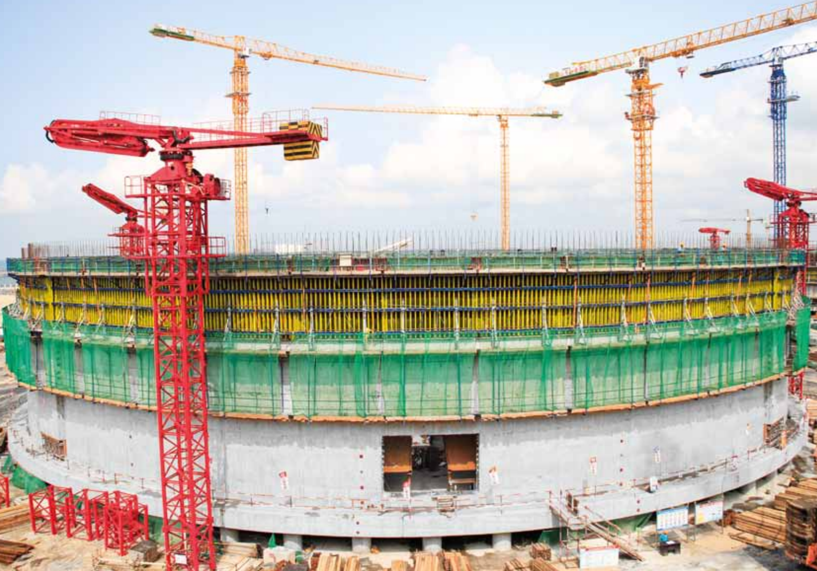
▲ Construction site of Guangxi Beihai LNG project
