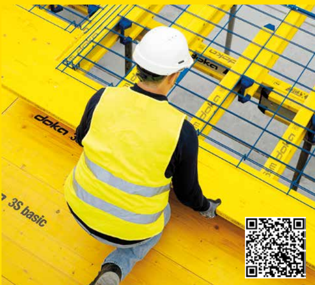
Nové bezpečnostné vylepšenie stropného nosníkového debnenia s posuvnou mriežkou Safeflex a so systémom Safeflex stanovuje nové štandardy v oblasti stability a bezpečnosti pri použití betónových prefabrikátov i monolitického betónu.
