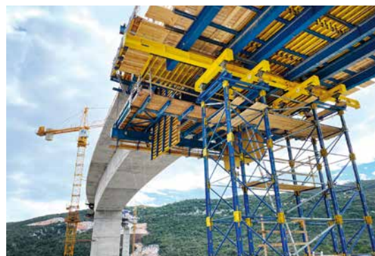
09 Realizácia mosta Dumanja Jaruga v Chorvátsku pomocou podperného systému Doka UniKit a Doka vozíkov letmej betonáže.
