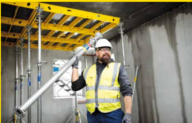
Nová stropná podpera Doka Eurex 20 kombinuje vyššiu nosnosť s nižšou hmotnosťou, čím zaisťuje ľahšiu manipuláciu a nižšie náklady pri všetkých systémoch stropov.
