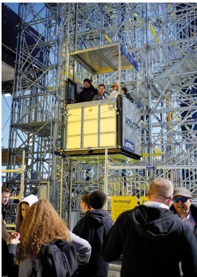
Výhľad na vyhlídkovú plošinu zostavenú z Doka lešenia Ringlock a podperného systému UniKit
