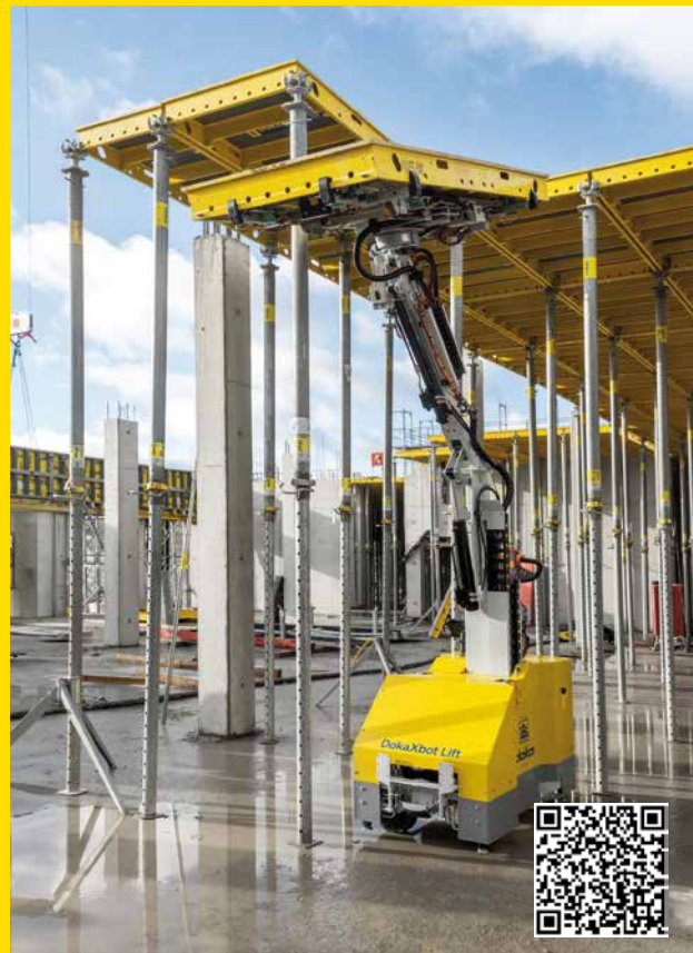
Vďaka intuitívnemu ovládaniu zo zeme, automatickým jemným úpravám a kompenzácií nerovností podlahy umožňuje DokaXbot Lift presné umiestnenie debniacich prvkov až do výšky 5,7 metra.
