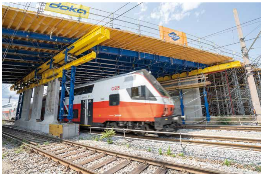
08 Doka UniKit nasadený na železničnom nadjazde v Rakúsku. © Doka
