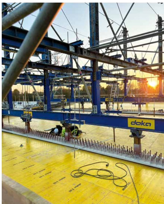
Doka debniaci vozík pre spriahnuté mosty so zaveseným nosníkovým debnením Top 50.
