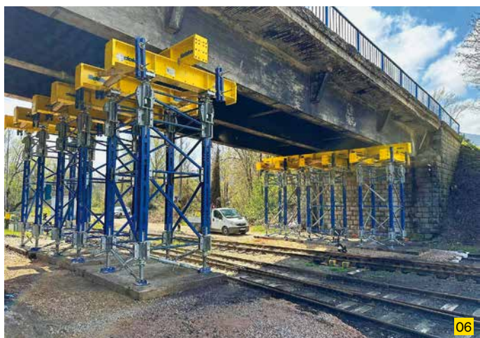
06 07 Prvé nasadenie podperného systému UniKit (UniKit podperná veža 480 a UniKit nosníky) na Slovensku ako dočasné podopretie mosta v havarijnom stave.
