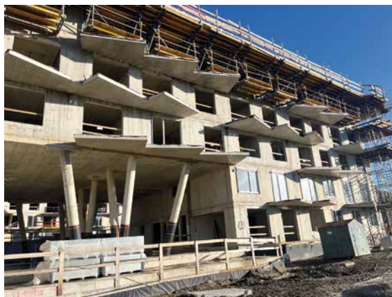
Podopretie nerovnomerne rozmiestnených balkónov sa realizuje pomocou zavesených plošín, vytvorených priamo na mieru pre tento projekt.
