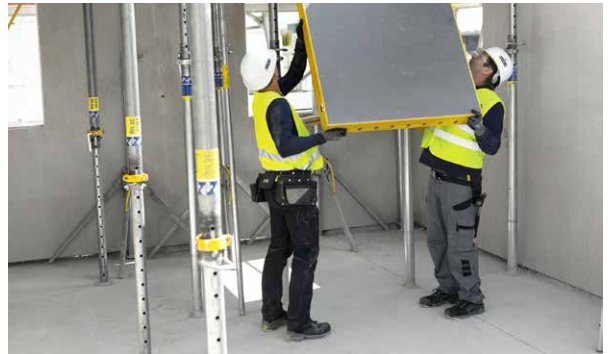
Die DokaXdek Element-Deckenschalung ist ein leichtes und flexibles 2-Mann-Elementsystem.
