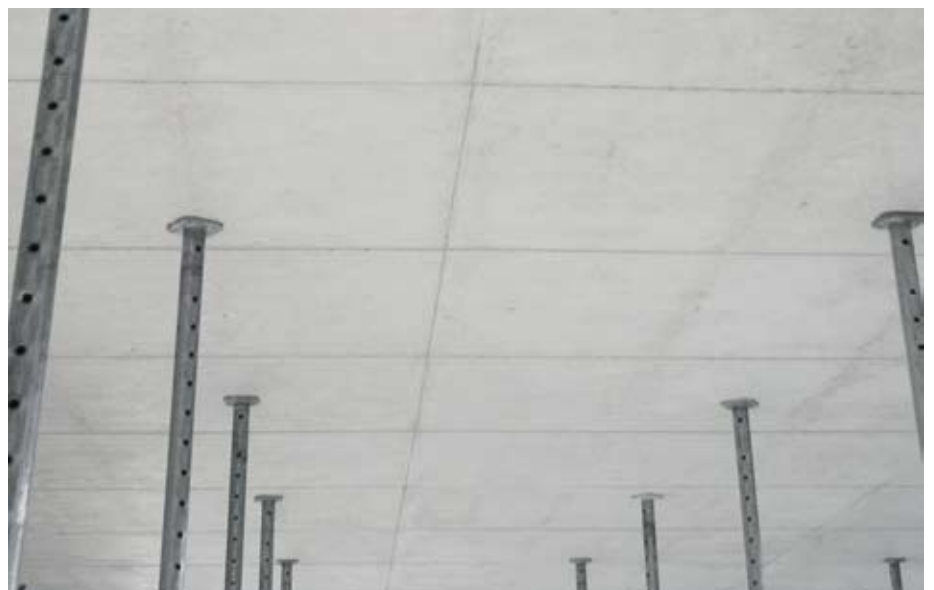
Des sous faces de dalles qui peuvent être apparentes: Le panneau Xlife garantit des surfaces lisses de cadres, et d'obtenir un joint esthétique et impeccable.
