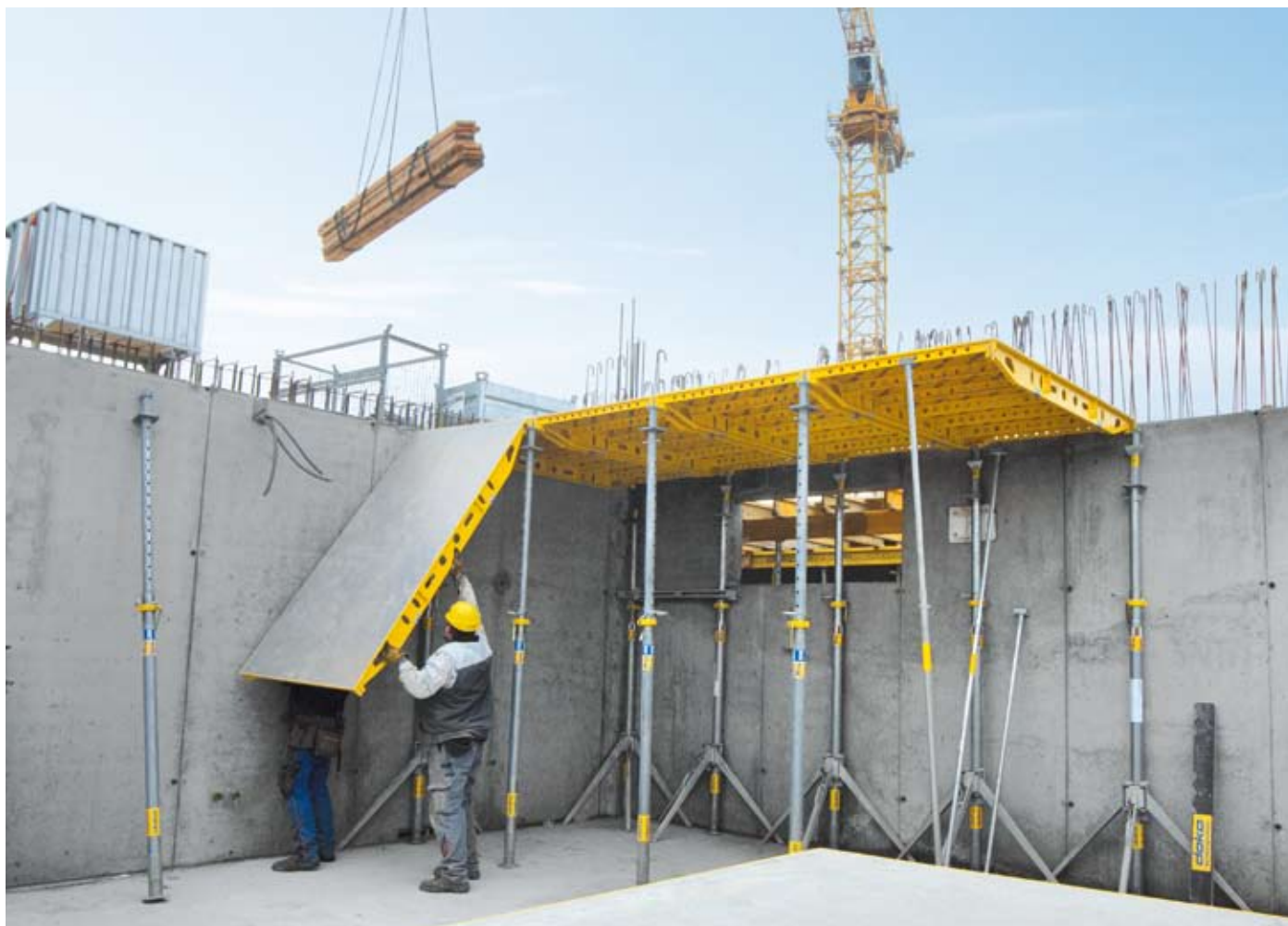
Coffrage manuel à partir du sol: Le précieux recours à la grue n'est pas indispensable et celle-ci peut être utilisée pour d'autres travaux et permettre d'accélérer l'avancement du chantier.
