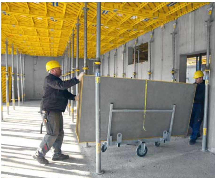
Le DekDrive s'adapte à toutes les largeurs de portes: Une translation rapide et ergonomique est également garantie pour la construction de cloisons.
