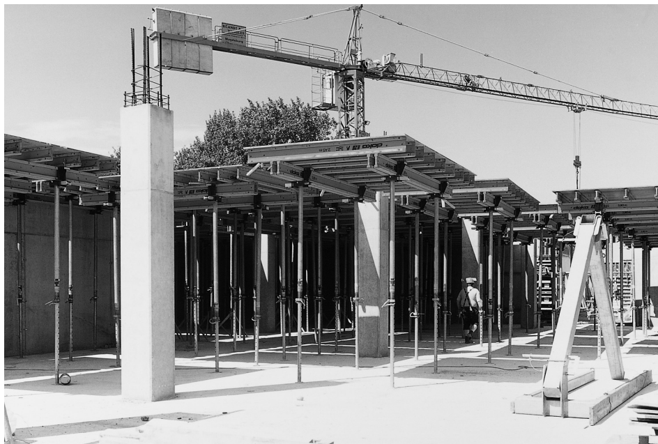
Rakennustyömaa: Yliopistonsairaala Magdeburg
