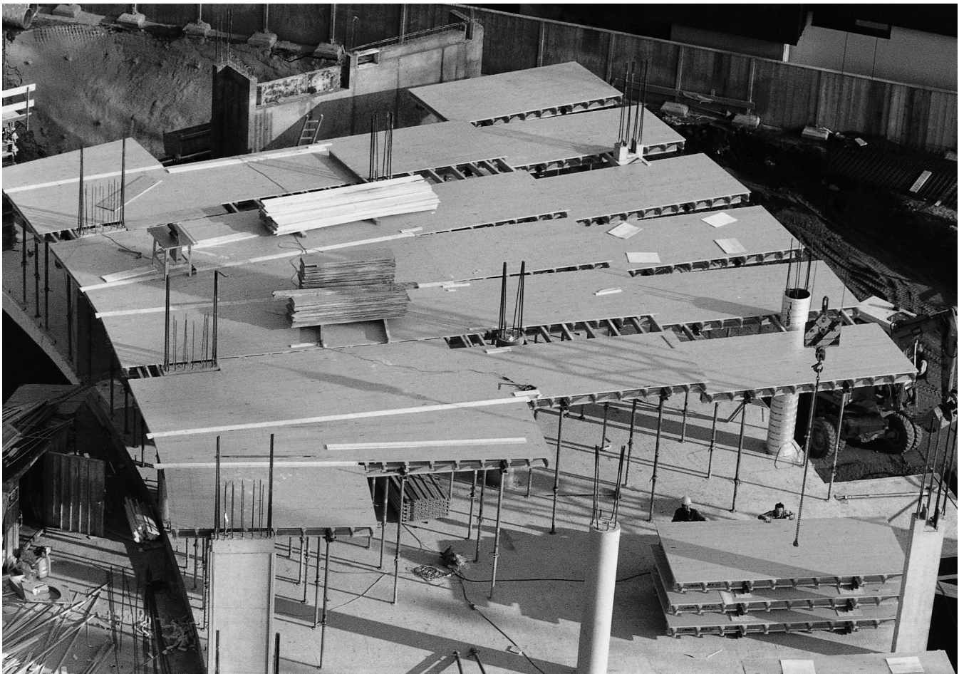
Rakennustyömaa: Kirurginen sairaala, Salzburg
