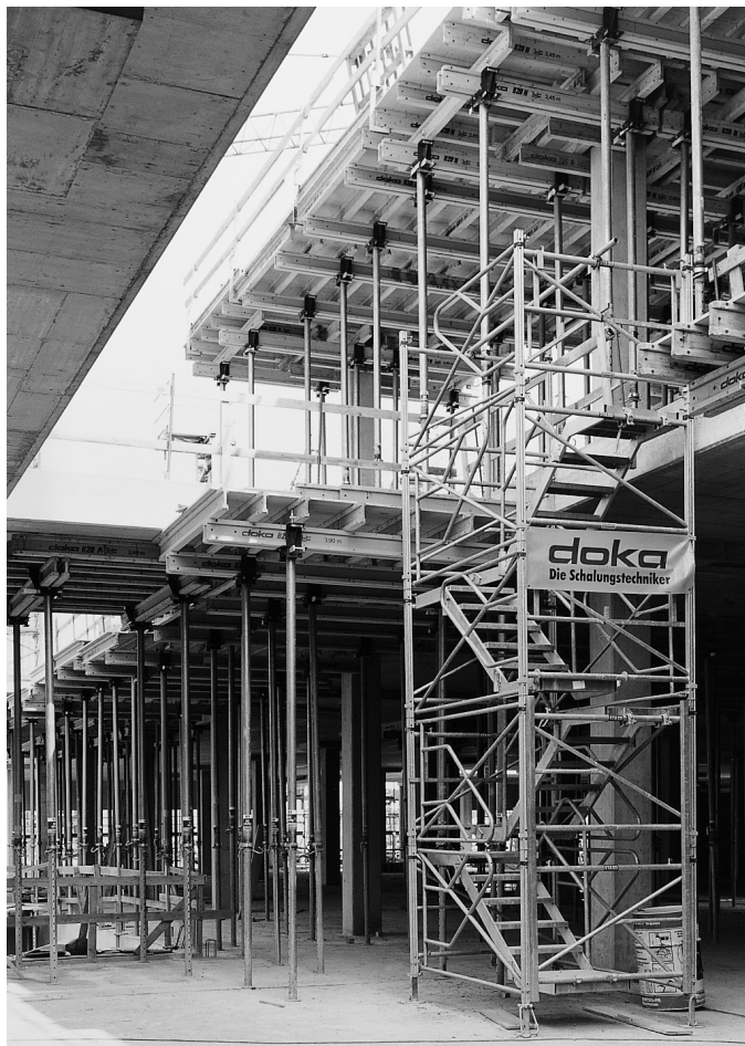
Rakennustyömaa: ARGE Westmünster Center, Bocholt
