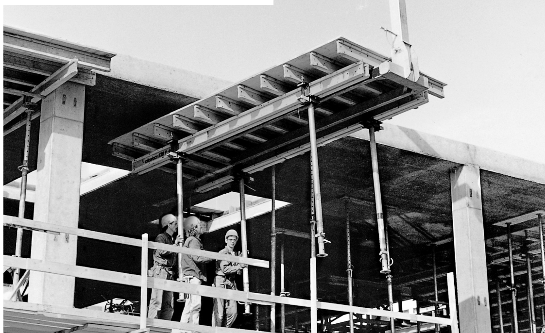
Rakennustyömaa: Varastohalli Klotzner, Linz
