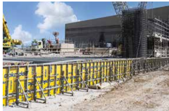
Erillisiä jäykistyksiä ei tarvita myöskään pitkissä linjauksissa.
