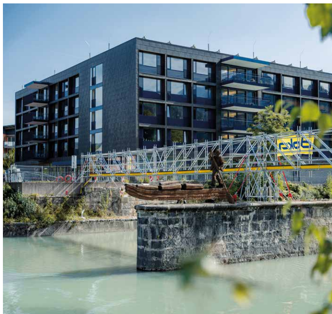
Ringlock impiegato come ponte sospeso provvisorio per l'attraversamento del fiume a Hallein, Austria.
