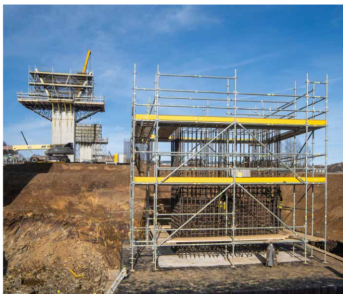
Ponteggio Ringlock per armatura che garantisce piattaforme di lavoro sicure per i ferrioli sui piloni del ponte Vystavda Estakada, Repubblica Ceca.
