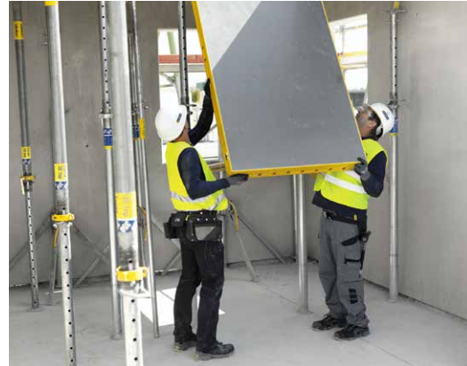
DokaXdek-muotit voidaan asentaa turvallisesti maasta käsin
