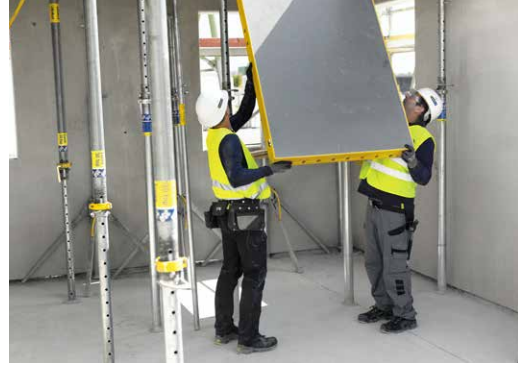
DokaXdek on kevyt ja joustava kahden henkilön muottijärjestelmä.
