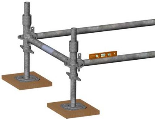
4. Empezando por el punto más alto del suelo, nivele la base utilizando un nivel y ajuste la tuerca mariposa de la placa base. Fije todas las cuñas con la ayuda de un martillo. Ahora que ha fijado la base, puede levantar la construcción del andamio en sentido vertical.
