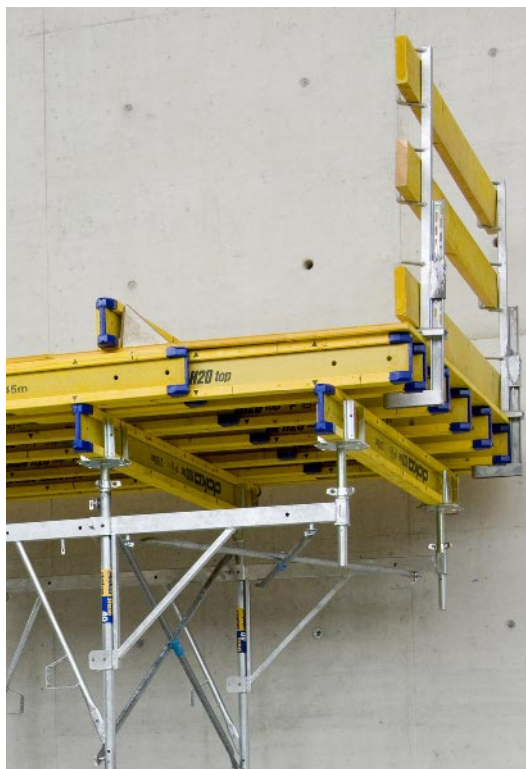
Консоли для безопасного выполнения работ на краю перекрытия
