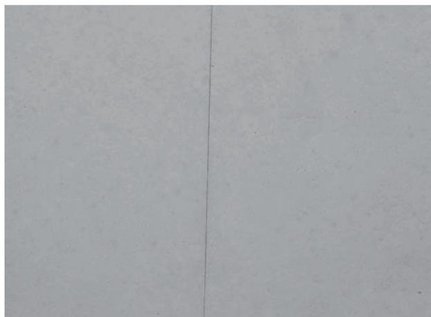
Joint de peau coffrante Dokaplex rendu étanche sur le parement béton
