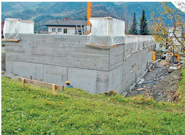
Protection du ferrailage de raccord (rouille)
