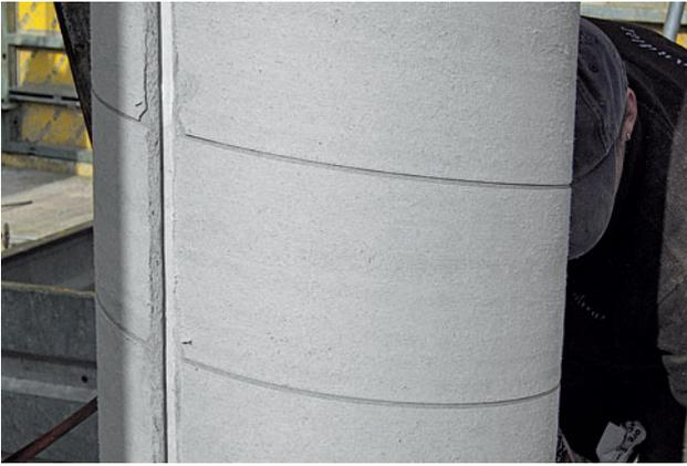
Parement béton en réalisation standard
