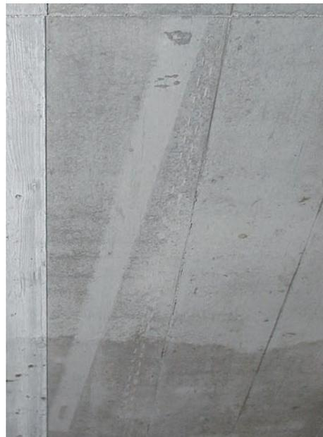
Décoloration du béton due au stockage d'une barre en alu sur la peau coffrante
