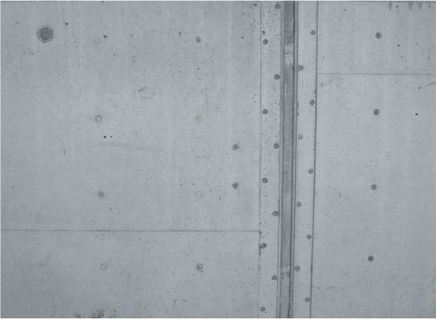
Vissage de la peau coffrante sur le bord (zone de jonction) des panneaux
