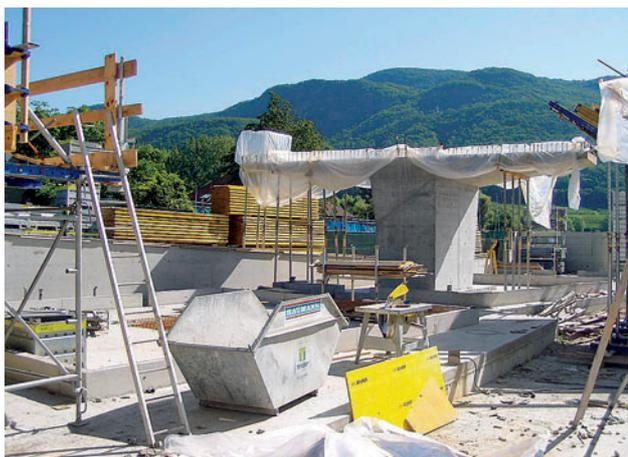
Protection du ferrailage de raccord (rouille)
