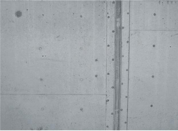
Verschraubung der Schalhaut im Randbereich (Stoßbereich) der Elemente
