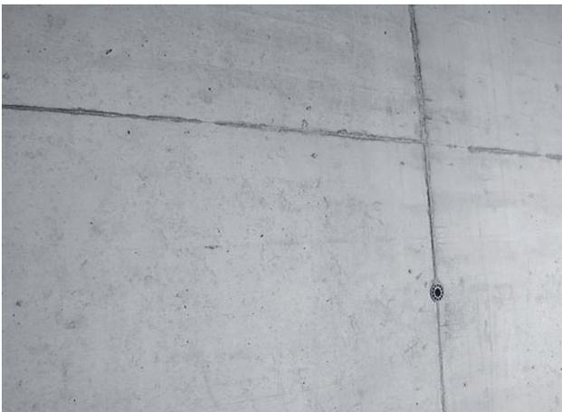
Betonbild bei Versatz im Elementstoß
