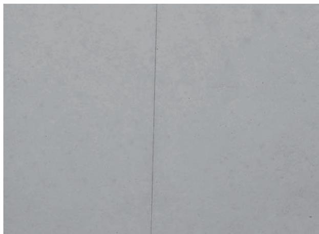
Betonbild Schalhautstoß abgedichtet
