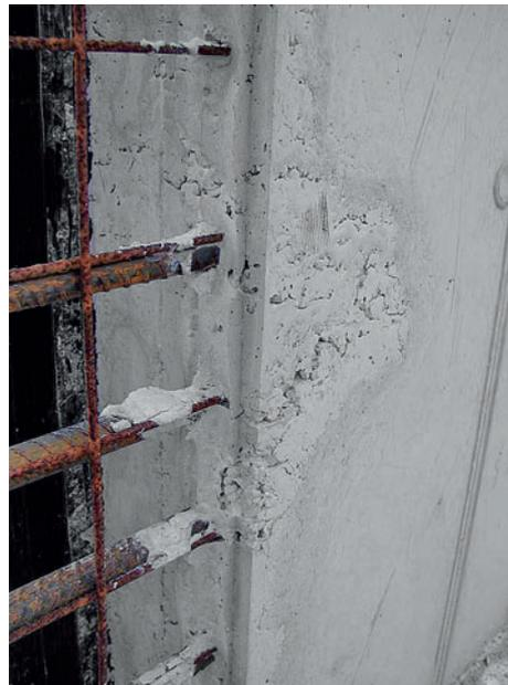
Ergebnis bei undichter Stirnabschalung
