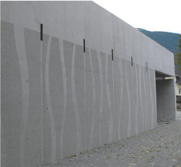
Behandlung mit Betonverzögerer und anschließendem Auswaschen der behandelten Bereiche
