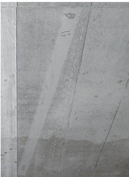
Betonverfärbung durch Lagerung einer Alu-Latte auf der Schalhaut
