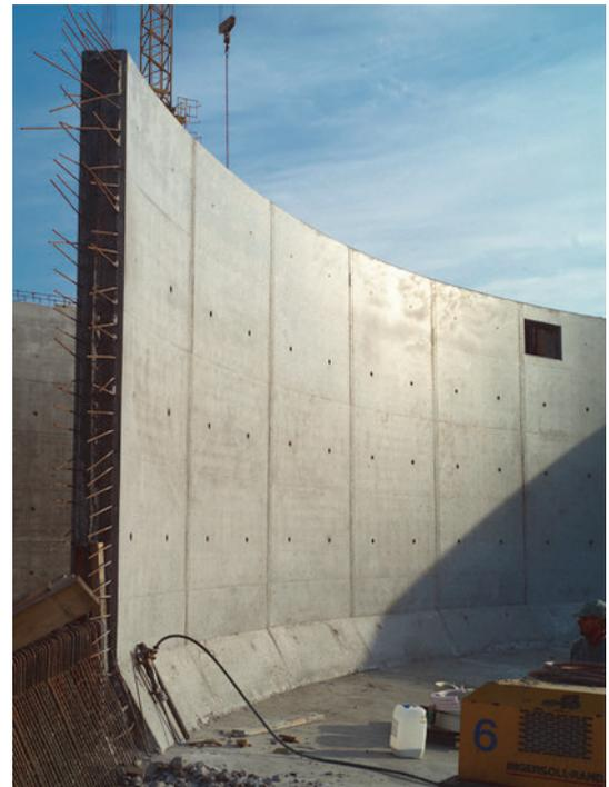
Seit vielen Jahren kommt Beton mit hohem Wassereindringwiderstand (wu-Beton) ohne zusätzliche Dichtungsschichten zum Einsatz.
