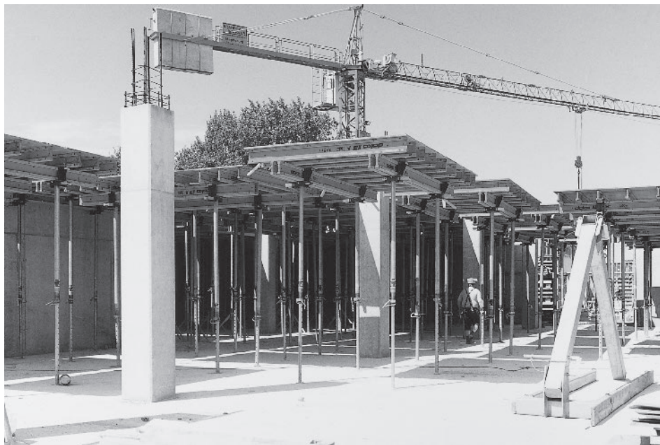
Rakennustyömaa: Yliopistonsairaala Magdeburg
