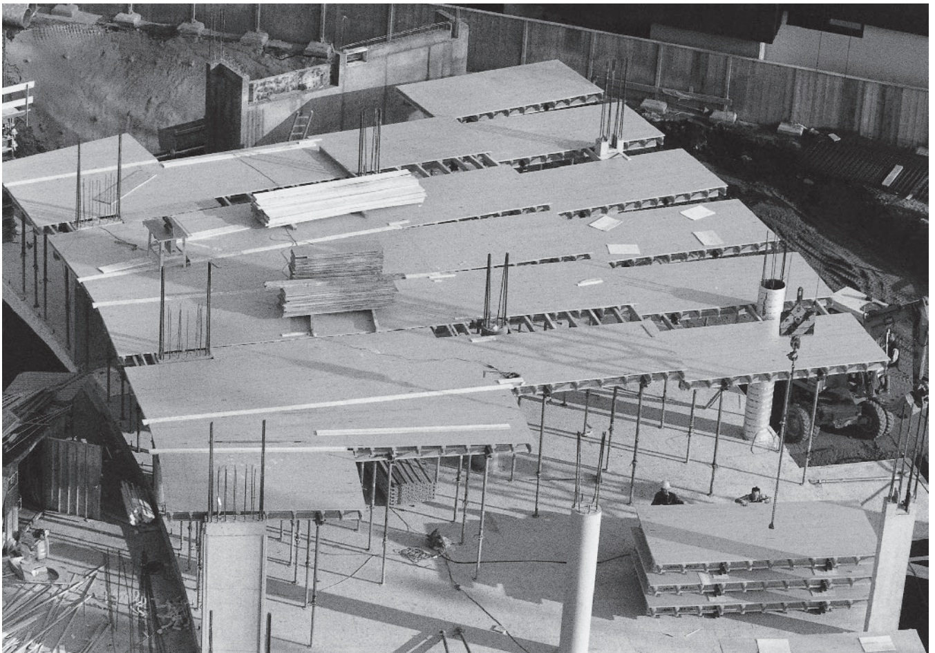
Rakennustyömaa: Kirurginen sairaala, Salzburg
