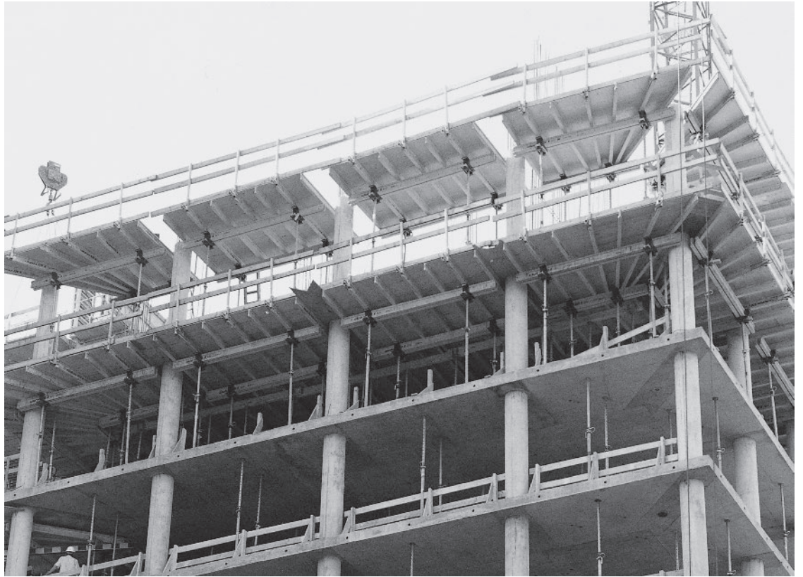
Rakennustyömaa: ARGE LVM kerrostalo Münster
