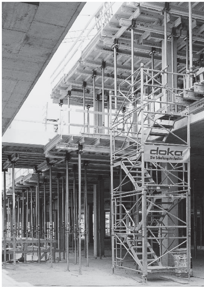
Rakennustyömaa: ARGE Westmünster Center, Bocholt
