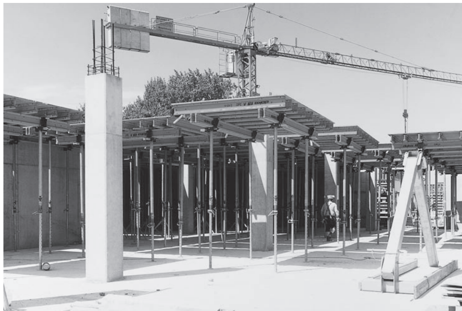
Obra: Hospital universitário, Magdeburg
