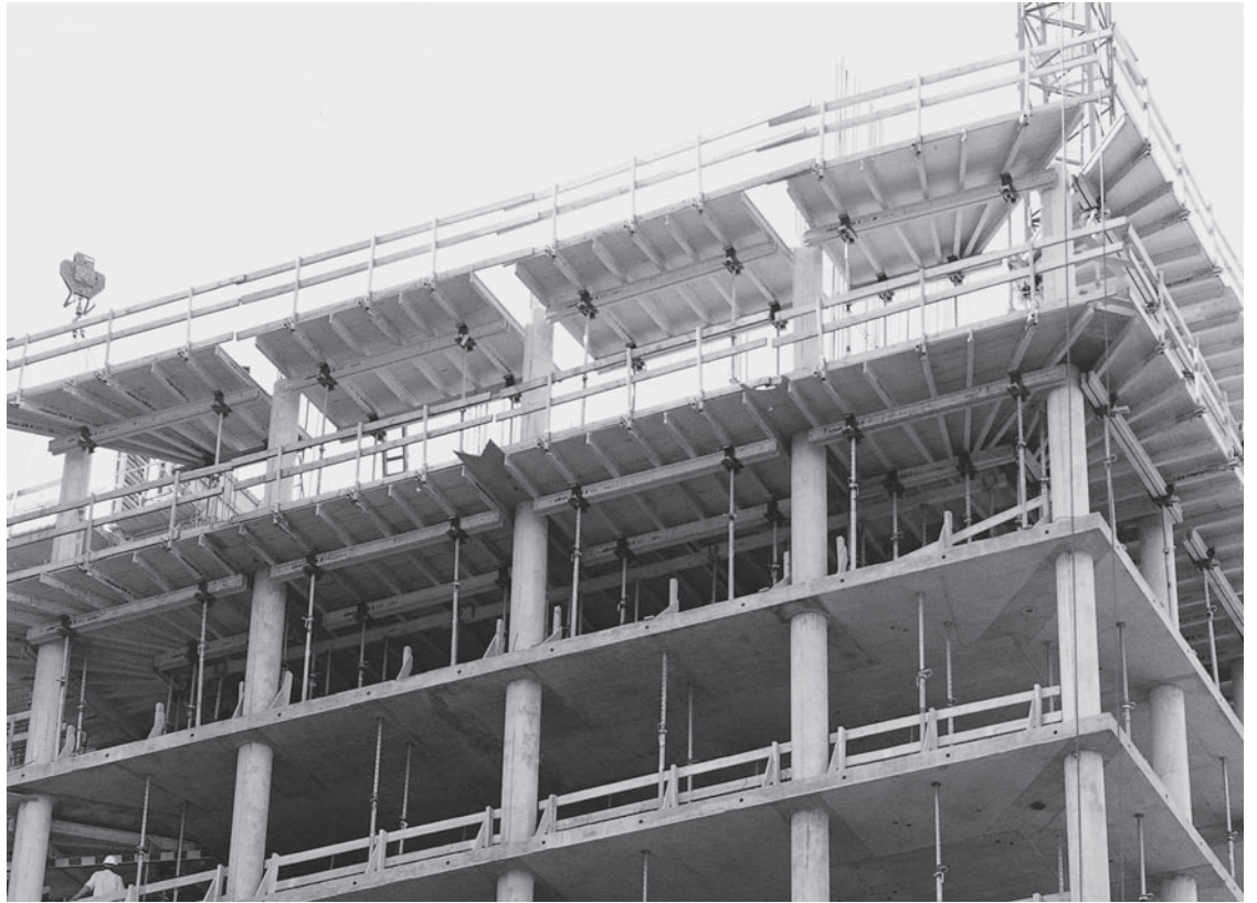
Obra: ARGE LVM Hochhaus Münster
