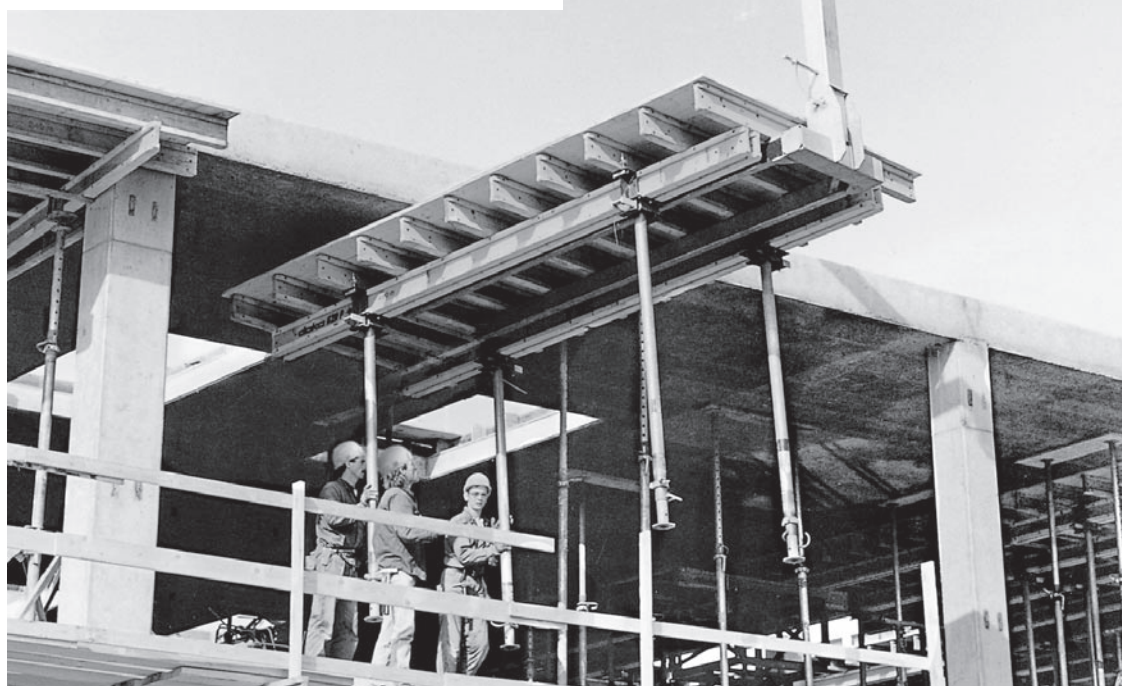
Obra: Armazém Klotzner, Linz
