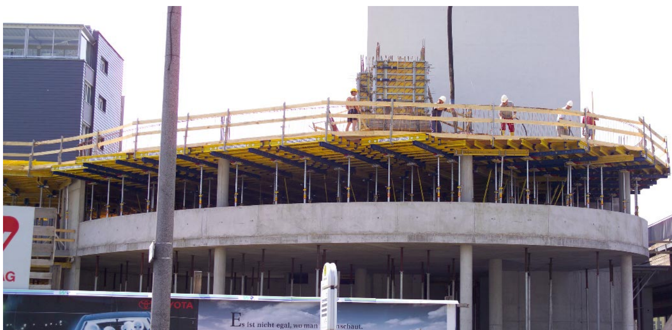
Staveniště: Lenaupark Linz
