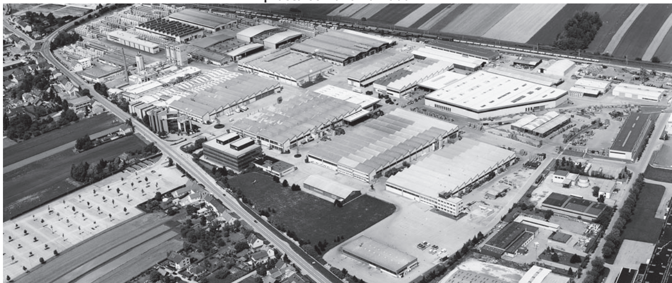
Fábrica central del grupo Doka en Amstetten
