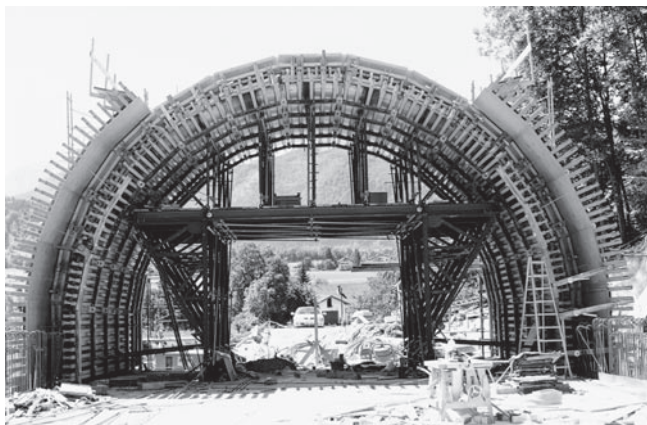
Építkezés: A Gluch patak hídja S34, Salzburg
