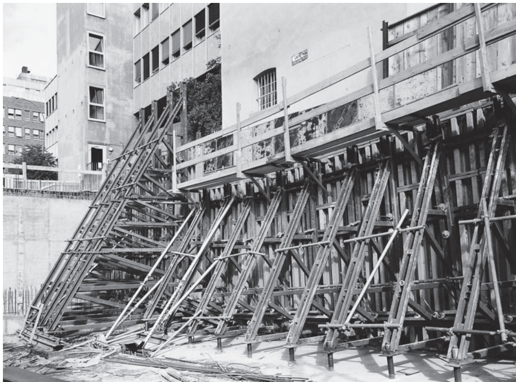
Építkezés: ARGE DLZ Mainzer-Landstra- ße, Frankfurt
