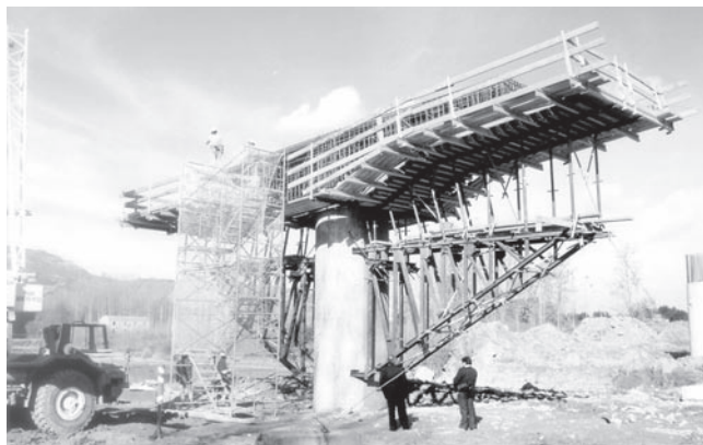
Építkezés: VIC-Manlleu, Spanyolország
