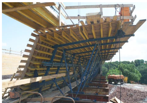
Építkezés: Híd a Geberggrund fölött, Németország
