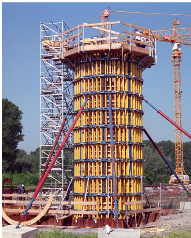
Építkezés: Ilverich rajnai átkelőhely, Meerbusch
