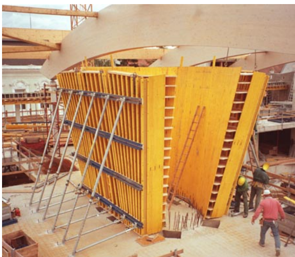
Építkezés: Városháza díszterme, Stockerau
