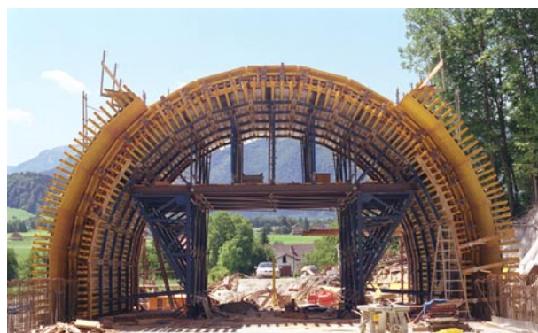
Építkezés: Gluckbach-híd S34, Ausztria
