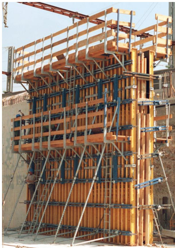
Építkezés: TVG Északi híd No. 4, Párizs
