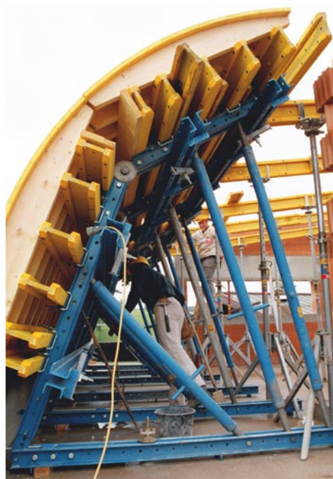
Építkezés: Új épület Candido, Saalfelden
