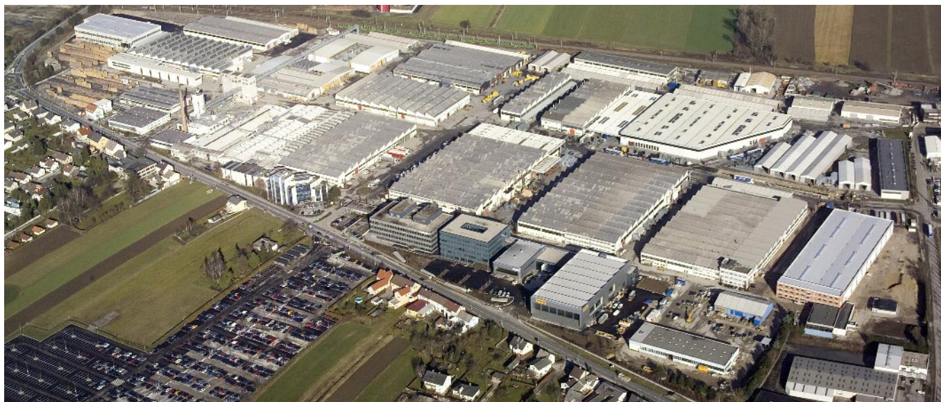
Κεντρικές εγκαταστάσεις Amstetten του ομίλου Doka
