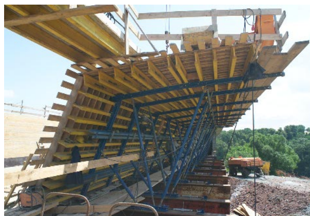
Obra: Ponte sobre o Gebergrund, Alemanha
