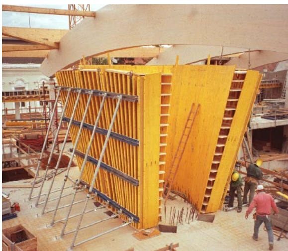
Obra: Fórum municipal Stockerau
