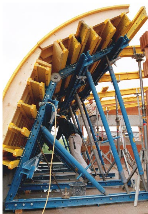
Obra: Novo edifício Candido, Saalfelden
