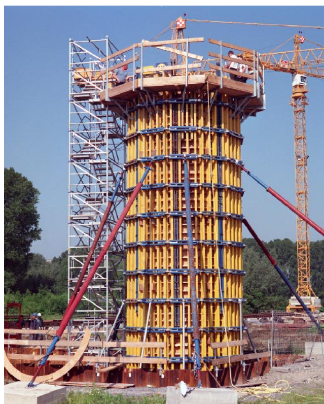
Obra: Travessia do Reno em Ilverich, Meerbusch
