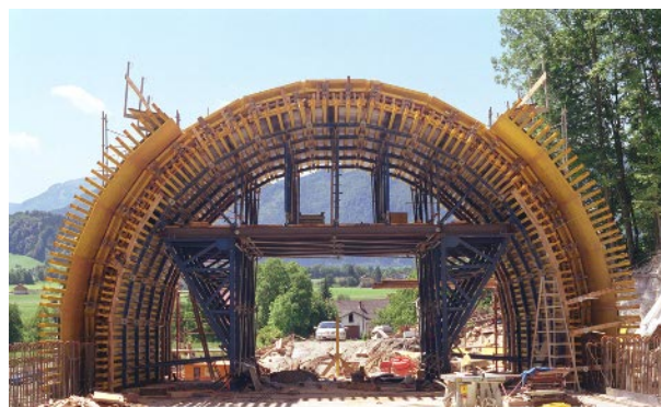
Obra: Ponte de Gluckbach S34, Áustria
