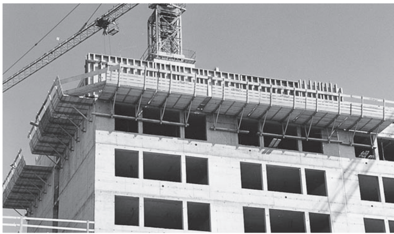
Építkezés: Erdberg lakónegyed, Bécs, Ausztria
