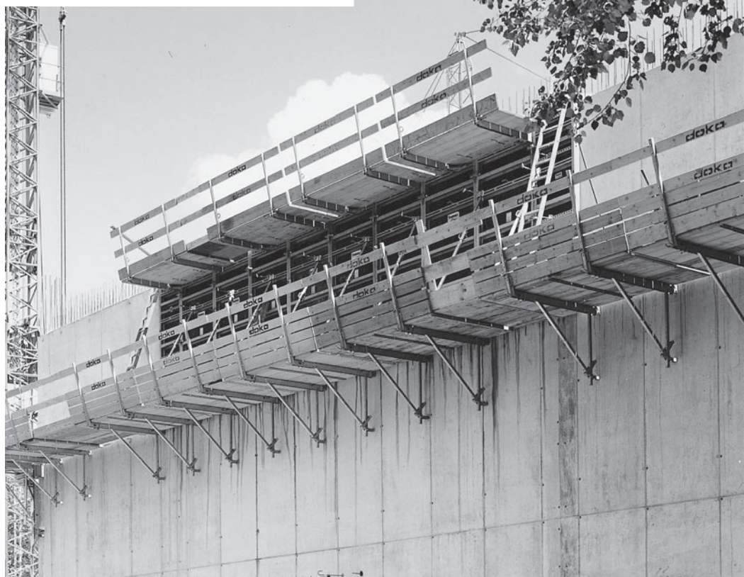
Építkezés: ARGE - Az ünnepi játékok házának kibővítése, Bregenz, Ausztria
