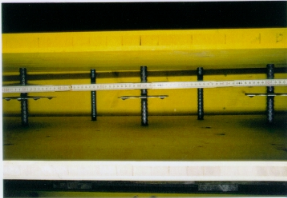
Bild 1: Blick in die Schalung mit der Wassersperre G 15,0
