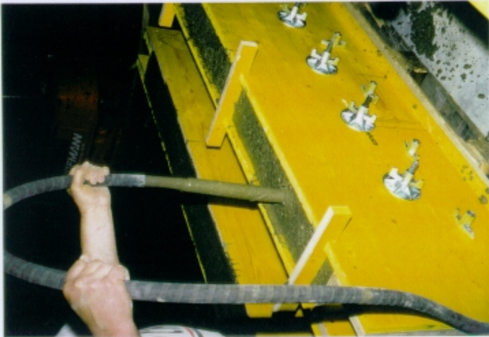
Bild 4: Betonieren der Modellwände
