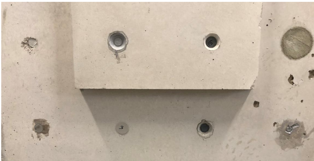
Bild 12: Detail der Spannstellen 1 bis 8 der Seite 2
