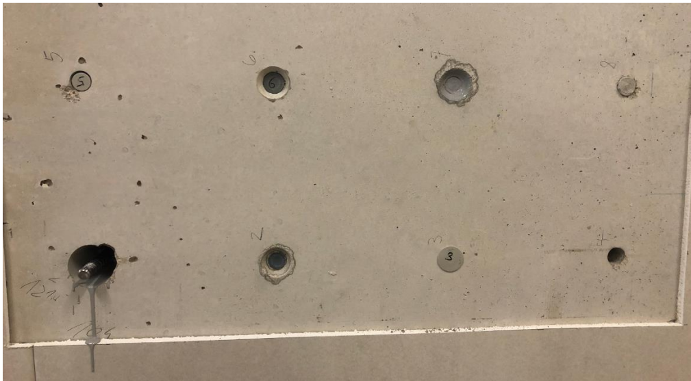
Bild 10: Detail der Spannstellen 1 bis 8 der Seite 1
