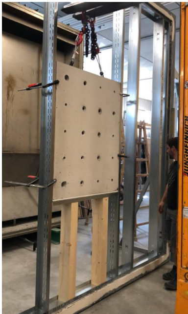
Bild 8: Einbau des Betonblockes (Seite 1)
