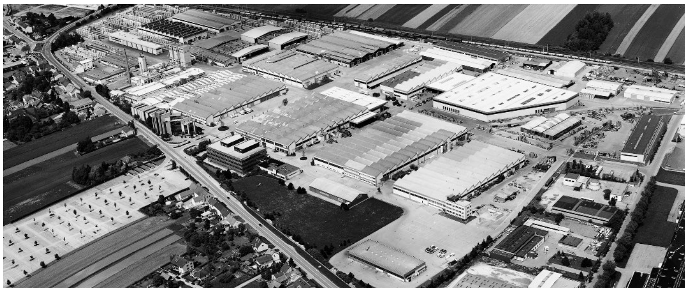
Usine centrale du groupe Doka à Amstetten (Autriche)
